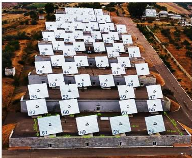
Рис.1. Гелиостатное поле (а) и картинки юстировочных визирных меток (б) На рис. 1. а) представлена схема расположения гелиостатов данной печи.
