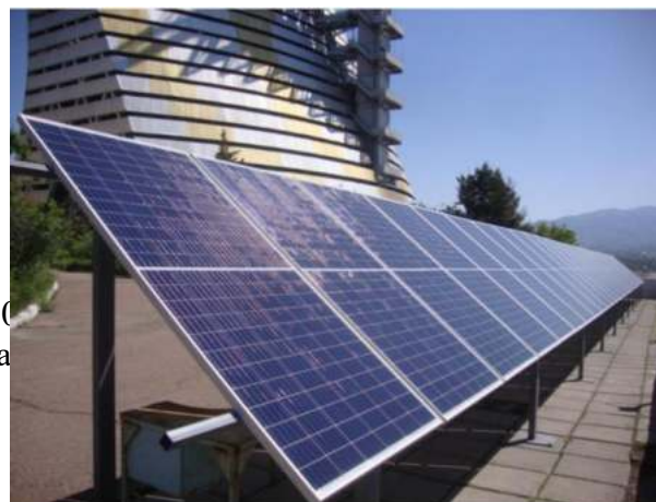
Рис. 1. ФЭС мощностью 10 кВт установленная рядом Большой Солнечной Печи института Материаловедения НПО «Физика-Солнце» АН РУз.
